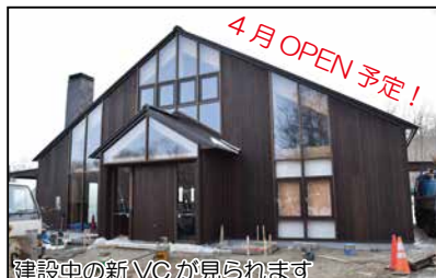
建設中の新VCが見られます
