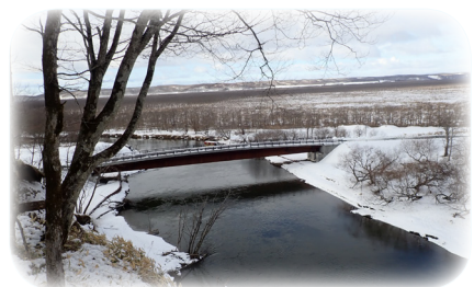
新しい「二本松橋」奥に古い橋脚が残る
